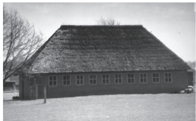
De voormalige fabrieksschuur Koningin Wilhelmina aan 57 (foto, collectie Drents Archief)
