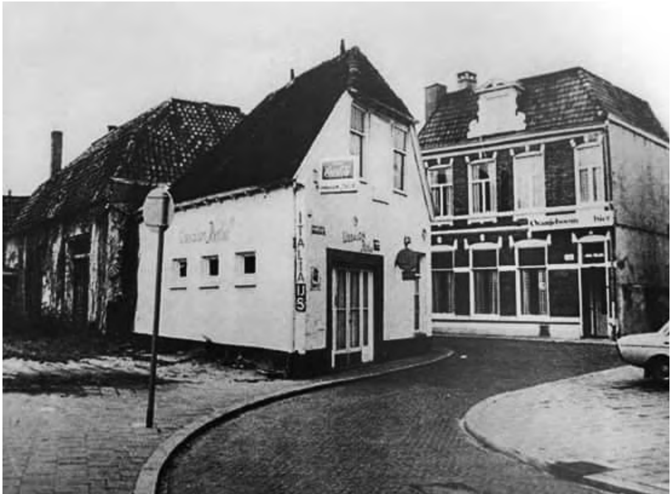
La Venezia en Het Bolwerk
